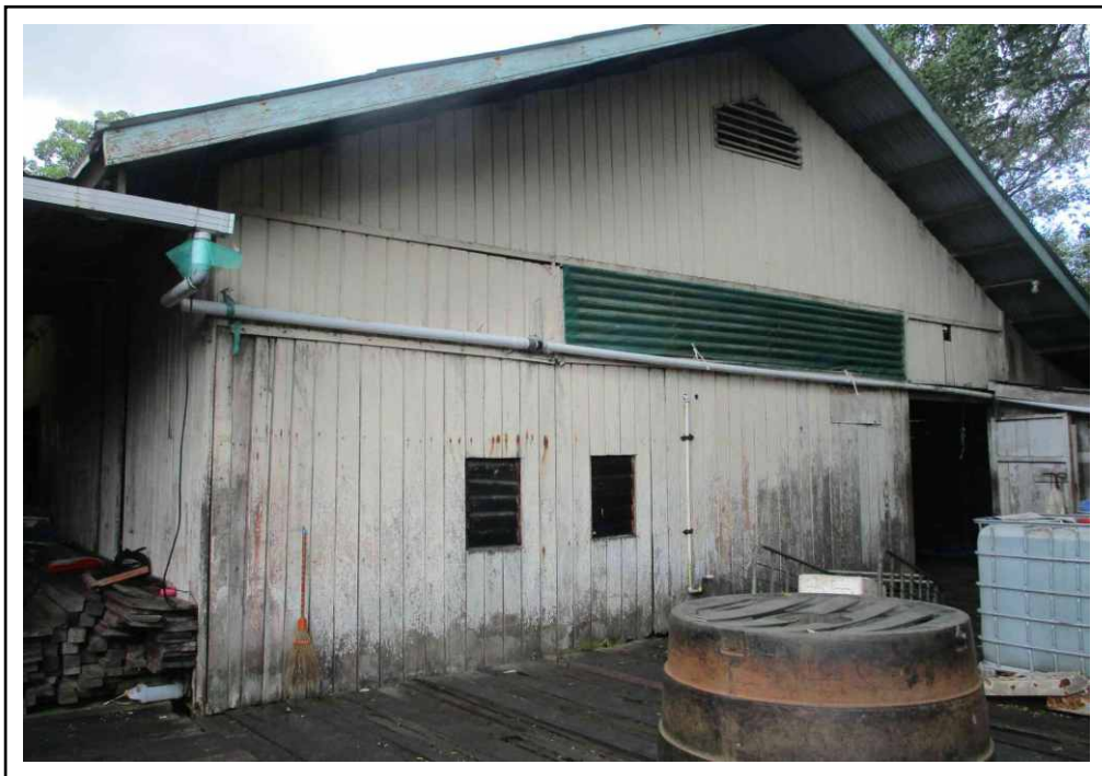
Kondisi Aset (Cold Storage)
