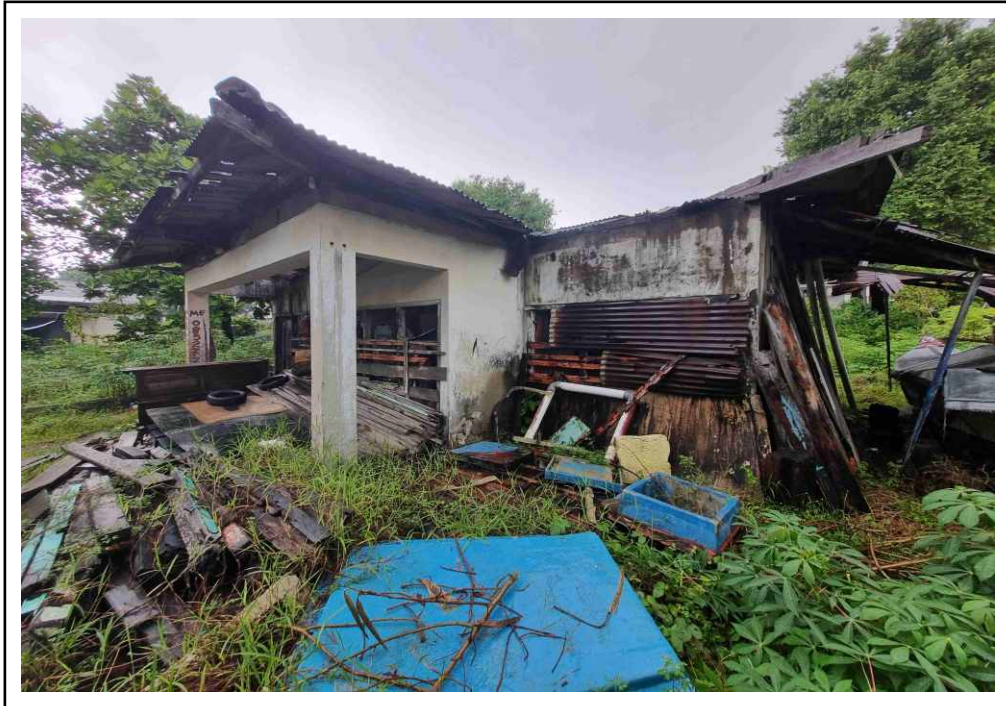
Kondisi Aset (Auditorium)
