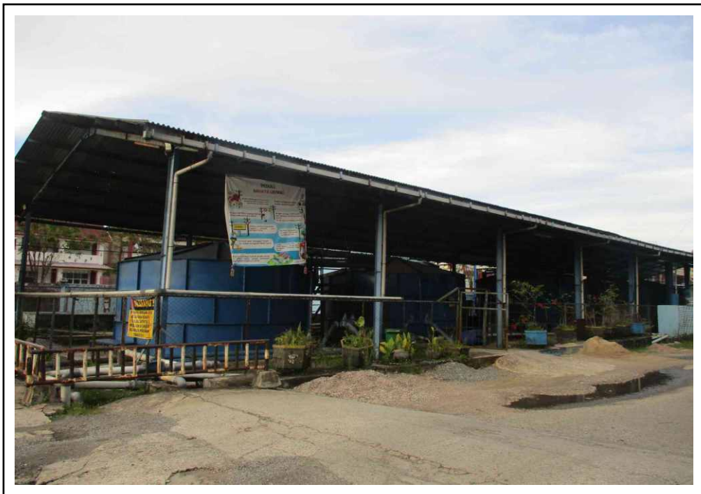
Kondisi Aset (Tandon Air)
