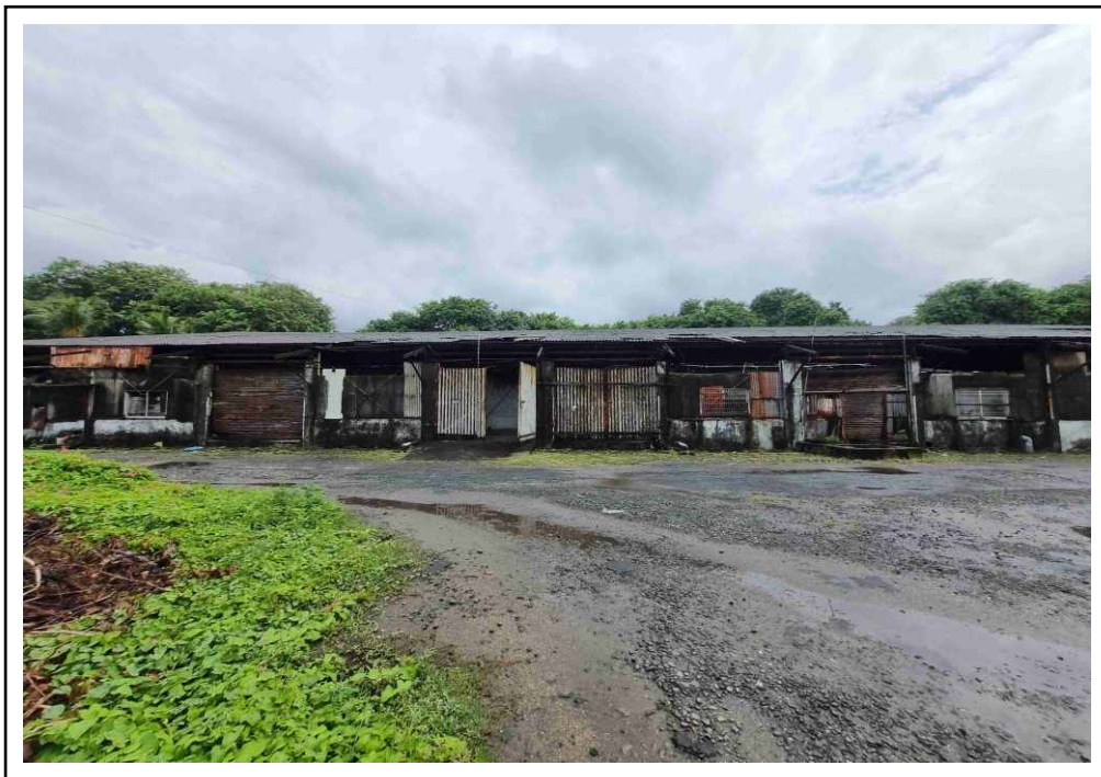
Kondisi Aset (Cold Storage)
