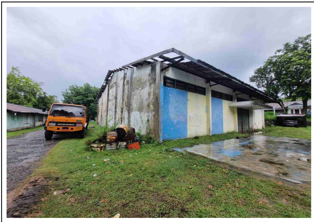
Kondisi Aset (Gudang)
