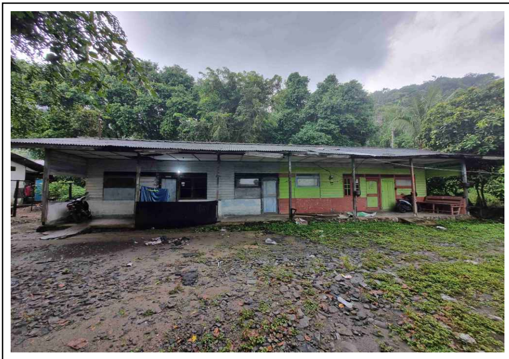
Kondisi Aset (Mess Kelasi)
